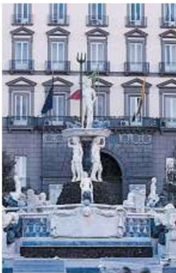
Palazzo San Giacomo È la sede degli uffici del Comune di Napoli
