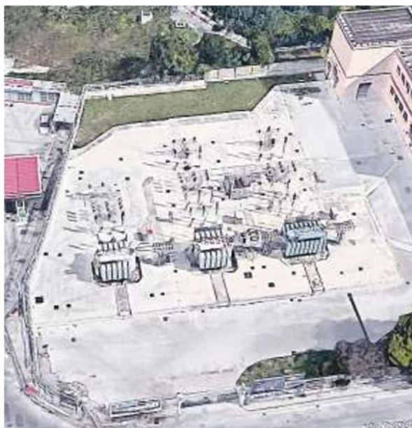
TERNA La nuova Stazione angolo via Terracina-Via Cinthia
